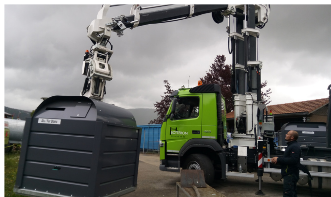
Installation de conteneurs aériens
